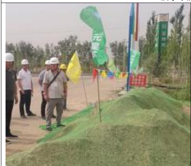
临时堆土防尘网苫盖
