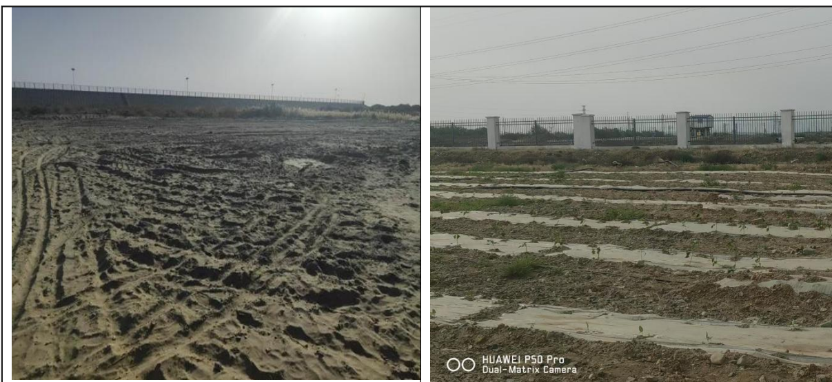
临时占地恢复
