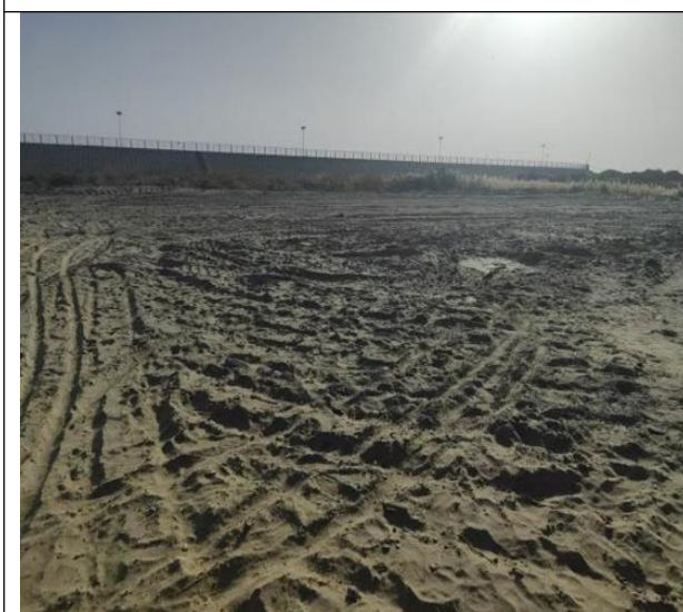
临时占地恢复
