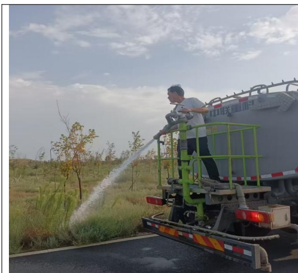
临时道路洒水
