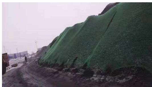
煤堆覆盖防尘网
