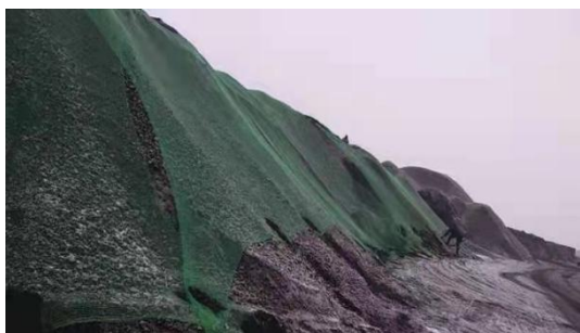
煤堆覆盖防尘网
