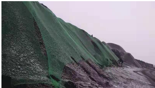
煤堆覆盖防尘网
